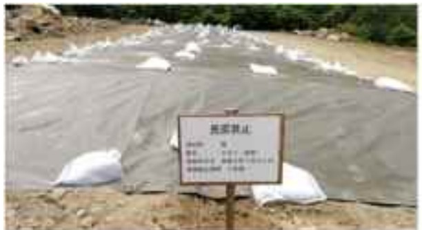
図5 埋却地での埋却を完了
