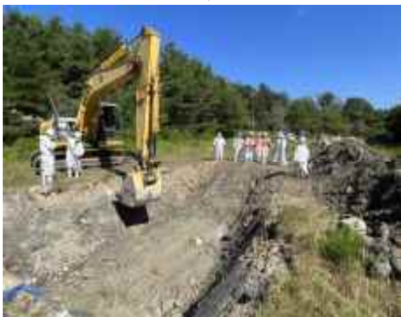
写真1 埋却候補地の試掘
