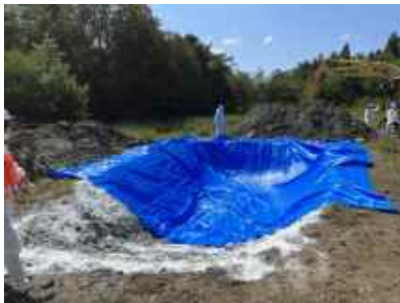
写真2 埋却溝へのブルーシート敷設
