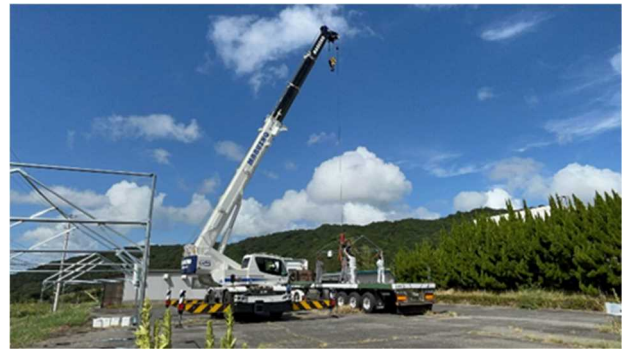
図5 ラフタークレーンの荷下ろし実演
