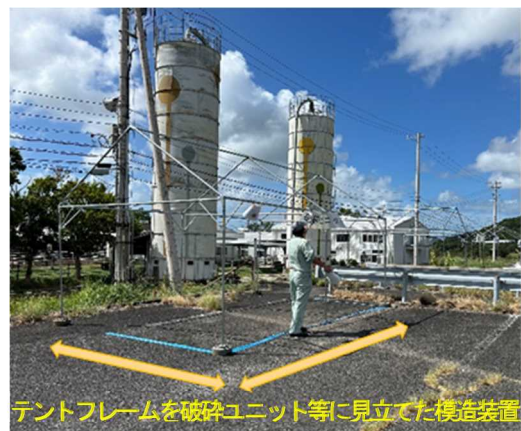
図6 模造装置を用いた作業工程の確認
