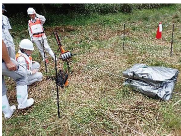
電気柵の設置
